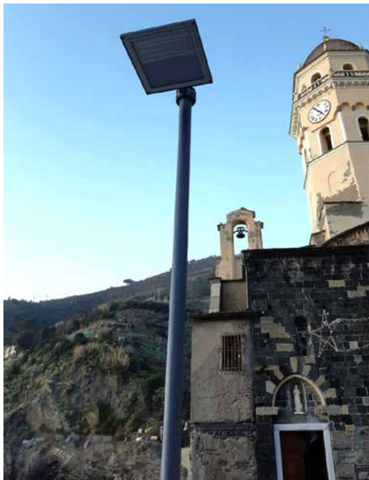
Figura 32. Illuminazione in Piazza Marconi dopo il restauro
