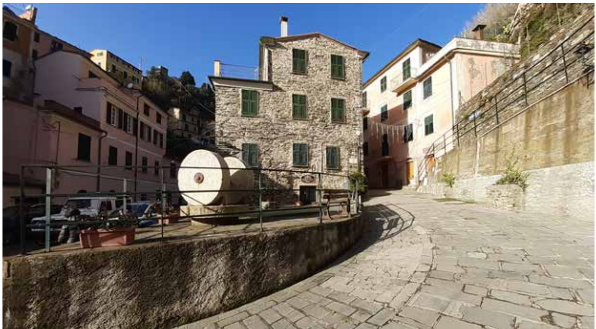
Figura 7. Utilizzo della pietra arenaria di Carniglia per le pavimentazioni
