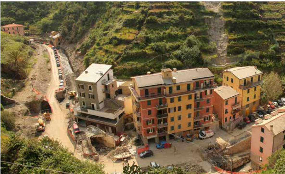
Figura 25. Il parcheggio dopo la pulizia post alluvione
